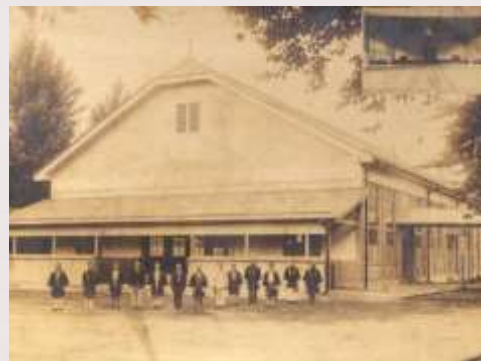
通明小学校旧体育館 施工:昭和4年
