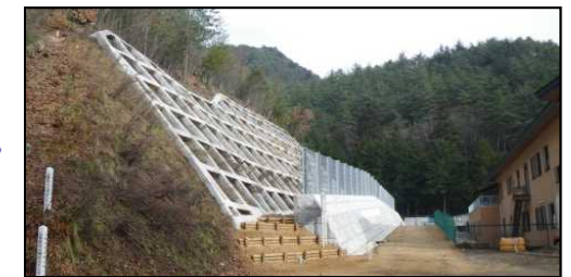
対策工事完了
