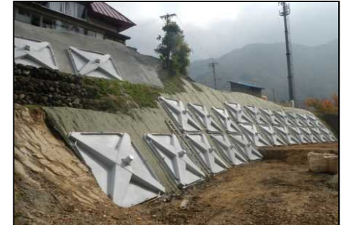
復興状況(竣工)
