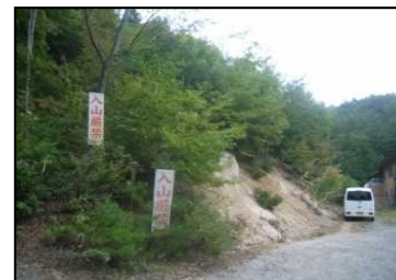
対策工事施工前
