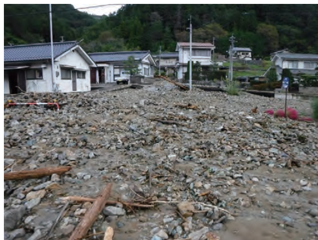
令和元年東日本台風 令和元年10月12日 土石流により被災した人家（上田市平井）
