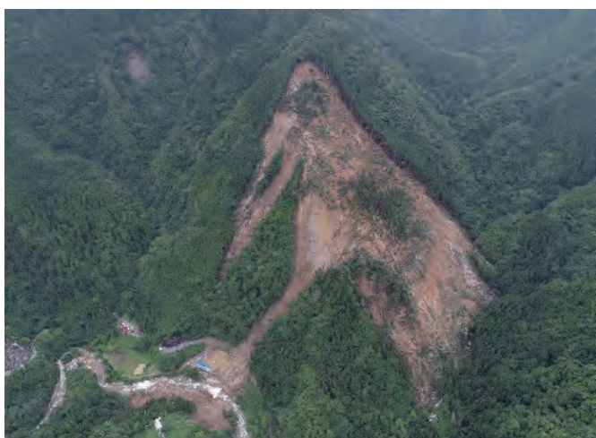
令和2年7月豪雨 令和2年7月12日 山腹崩壊により被災した国道418号（天龍村足瀬）
