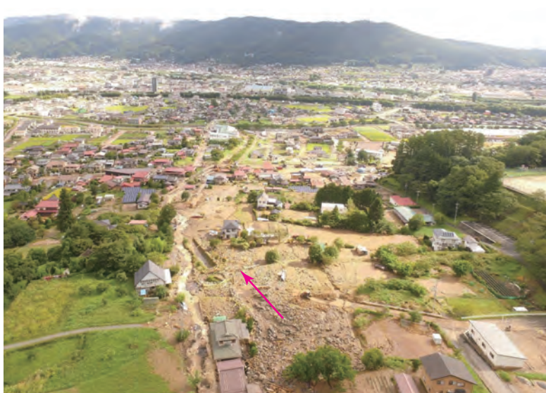
令和3年9月5日 土石流により被災した人家（茅野市高部地区）
