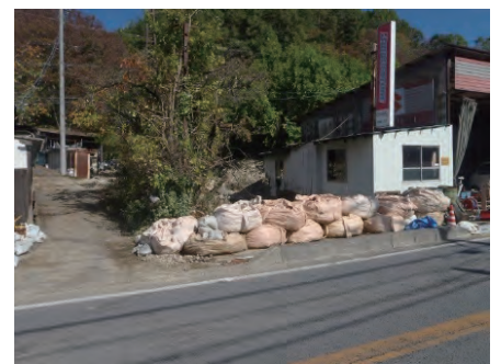
上田市茂沢 土砂流失発生状況（左）と大型土のうによる応急対応（右）
