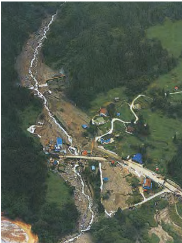
梅雨前線豪雨災害 平成 7 年 7 月 小谷村 湯原沢 土石流に巻き込まれた人家と道路
