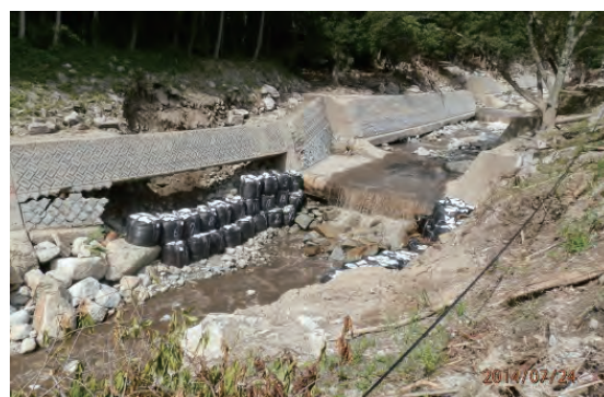
応急工事による仮設護岸
