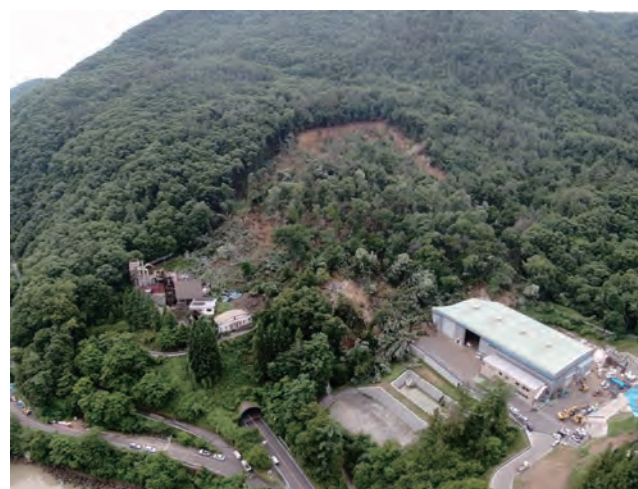
令和3年7月5日 地すべりにより通行止めとなった 国道19号（長野市篠ノ井小松原）
