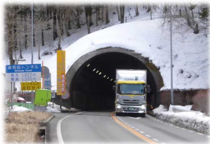
新和田トンネル
