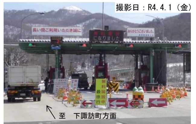
無料開放後の状況 (現在、料金所撤去等の工事を実施中)
