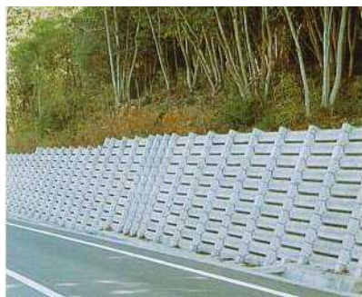
井げた組擁壁
