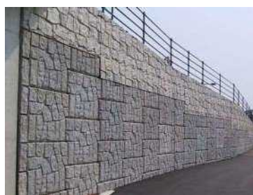
補強土壁(コンクリートパネル)
