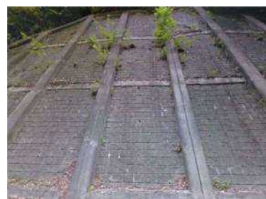
現場打ちコンクリート法枠
