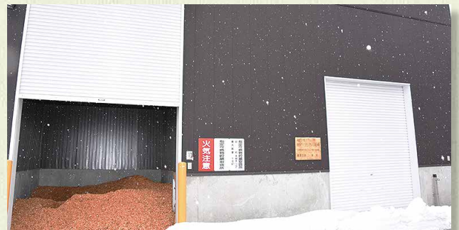
▲木質チップの倉庫
