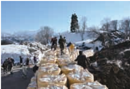
県北部地震 土石流の被害を警戒し、土のうを設置
