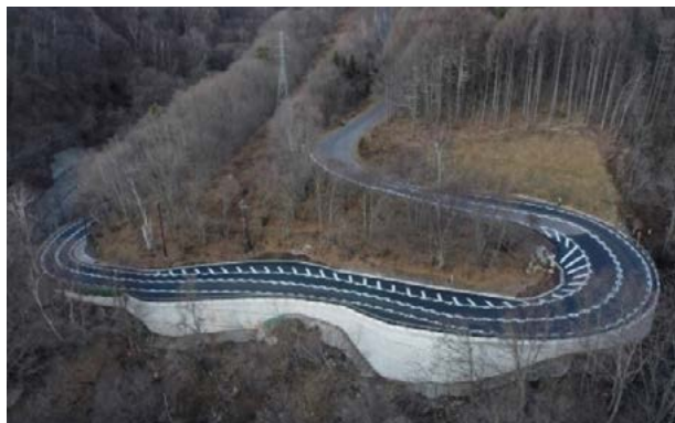
湯の丸高原へのアクセス道路の整備（東御市）
