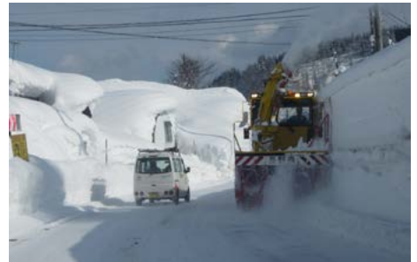
国道117号の除雪作業
