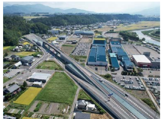
国道153号伊那バイパス
