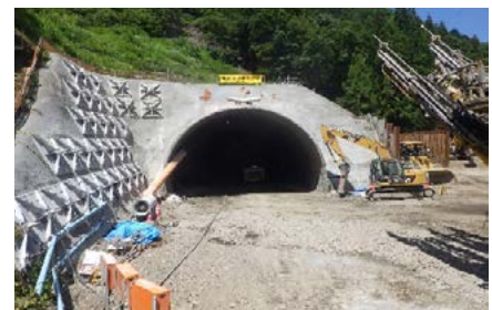
国道158号狸平トンネル工事（松本市）
