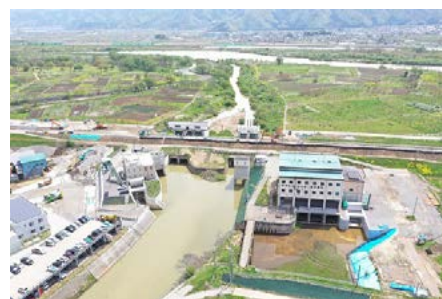
浅川排水機場
