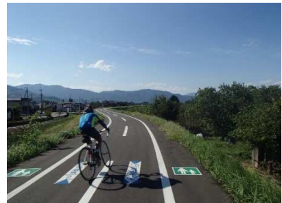
千曲川サイクリングロード リニューアル区間
