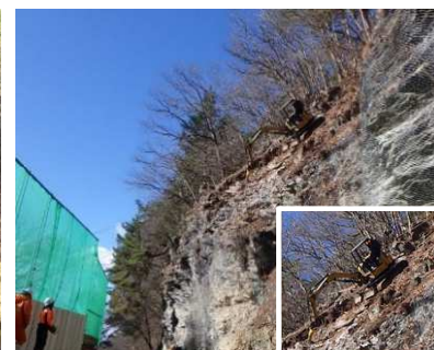
■ 斜面对策 ICT建機による無人化施工
