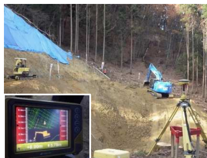
■ 砂防堰堤 ICT土工施工状況
