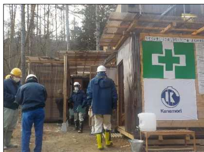
建設業協会女性部会と若手技術者による 合同現場点検
