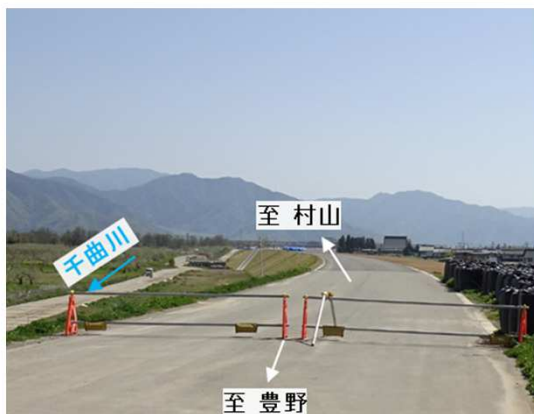
(堤防工事と合わせた道路整備)
