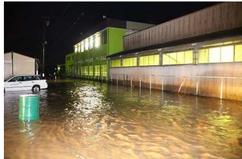
平成22年8月豪雨 (一) 矢出沢川 上田市
