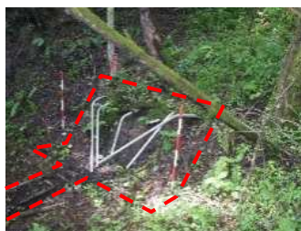
■ 地すべり防止施設の修繕
