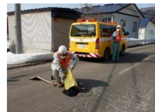
■ 道路パトロールによる日常的な維持管理
