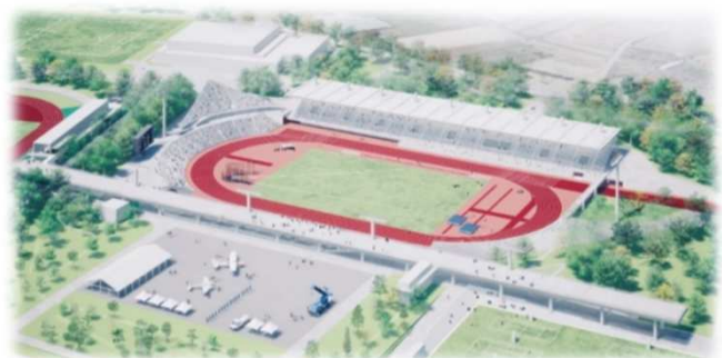
全景（空港側より）
