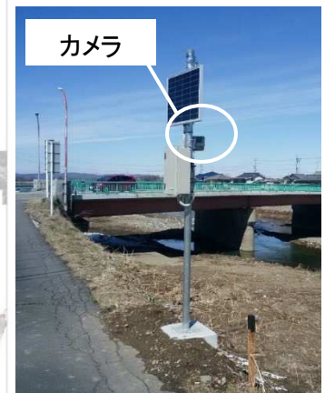
簡易型河川監視カメラの設置
