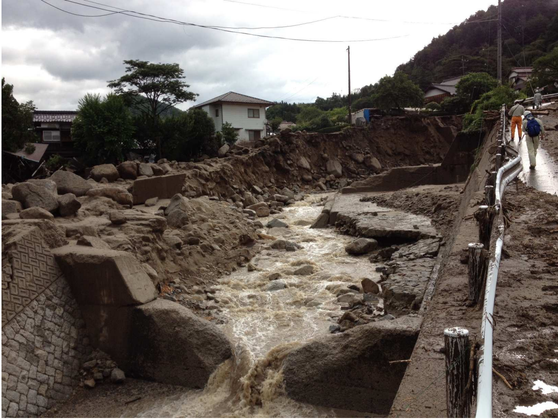
(南木曾町梨子沢土砂災害)
