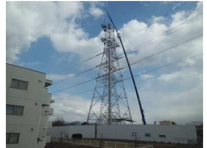
(送電線建設工事 提供：中部電力(株))
