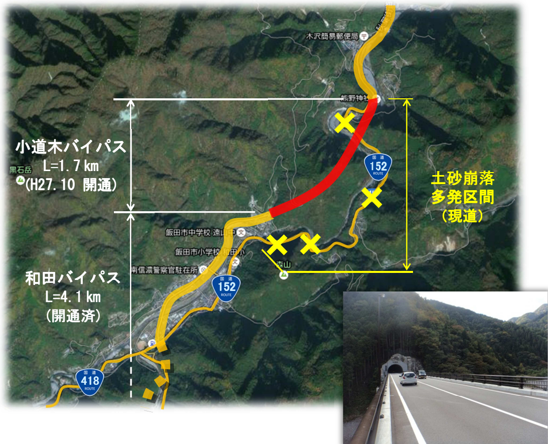
【図 4-4-1 例 緊急輸送路の整備（一般国道152号 飯田市 小道木バイパス）】（長野県道路建設課）
