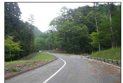
（県営林道の開設状況 林道大島氏乗線）
