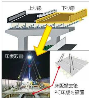
▶ 工事の概要(床版取替え)
