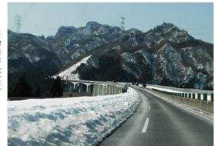
(H26.2 大雪時の通行確保状況 提供：NEXCO東日本)
