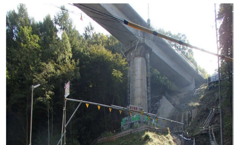
(橋脚耐震補強工事 提供：JR東日本)
