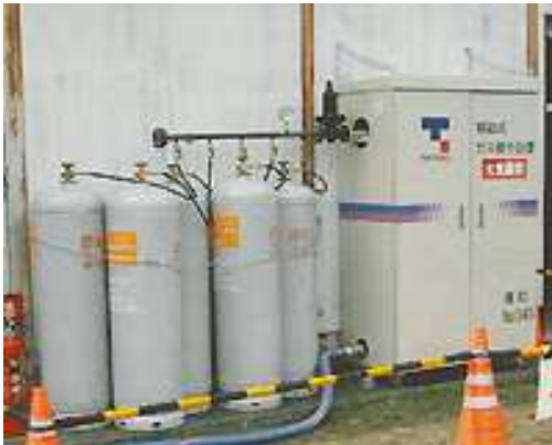
【図 4-1-8 移動式ガス発生設備】 圧縮天然ガス等をポンペに充填して、ガスを供給する設備です。病院等に臨時供給します。
