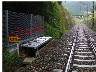
（土石流を検知するセンサー 提供：JR東海）
