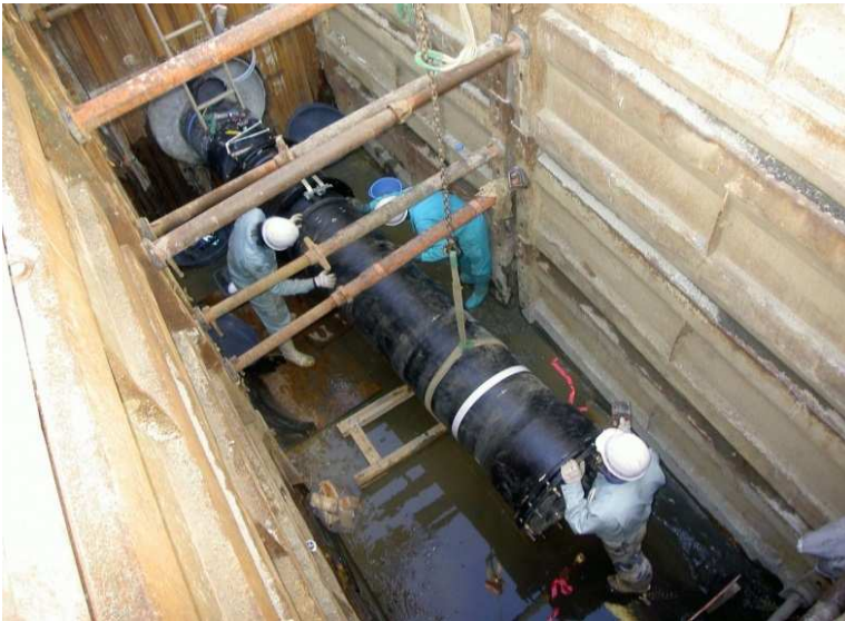
(水道管耐震化工事の状況 長野県企業局)
