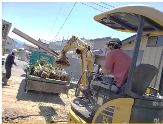
重機を持ち込み災害ごみを撤去
