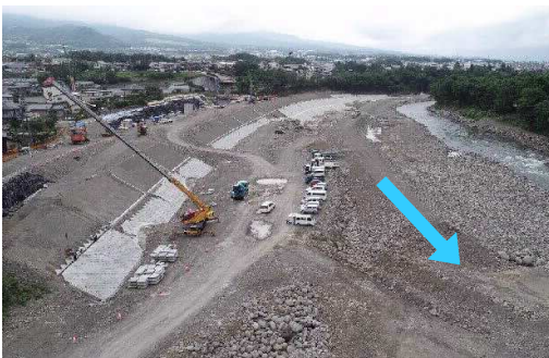
【施工中】東御市 海野地先
