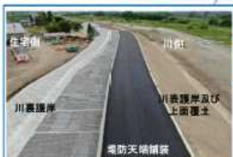
堤防強化(粘り強い河川堤防)
