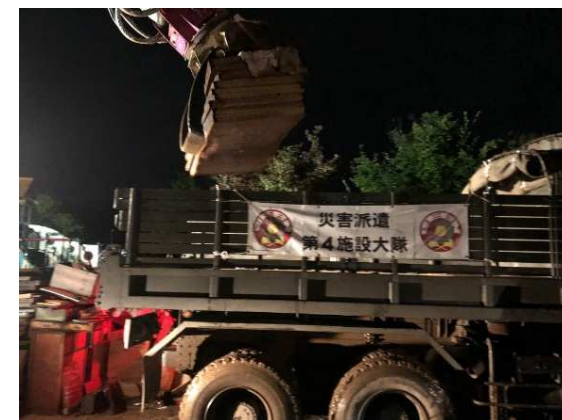
自衛隊による搬出作業
