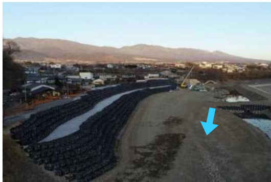
【再施工中】東御市 海野地先
