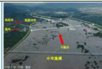
立ヶ花狭窄部掘削
