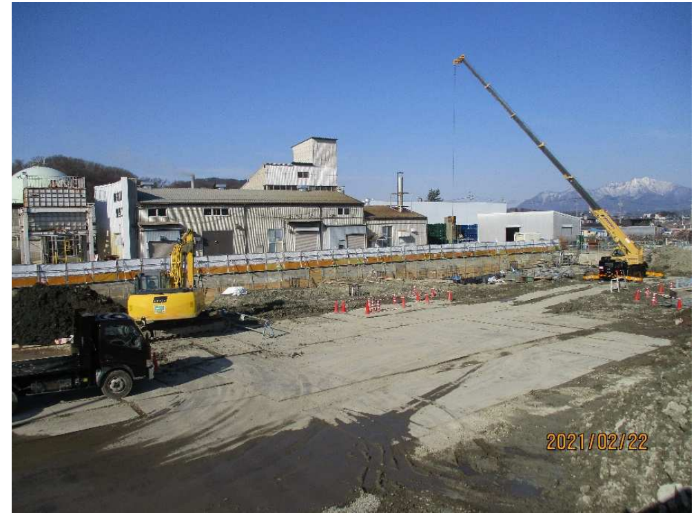
食品製造工場の建替（令和3年2月22日撮影）
