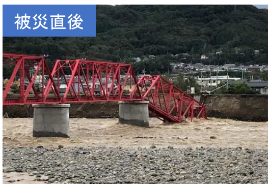
上田電鉄(株)上田駅～城下駅間橋梁
