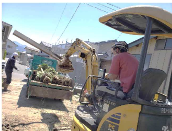
重機を持ち込み災害ごみを撤去
