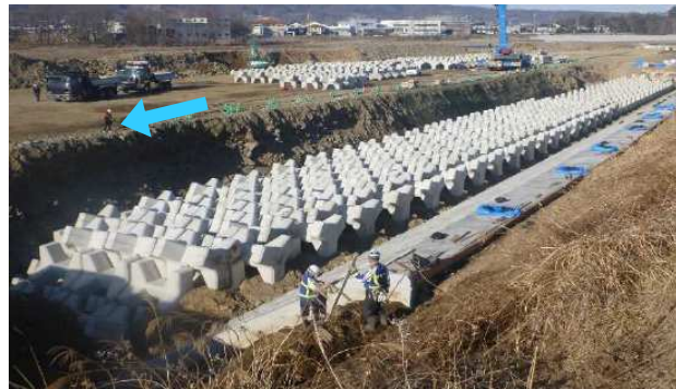
【施工中】佐久市 原地先
