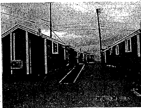
トレーラーハウス（駒沢新町第2団地）
