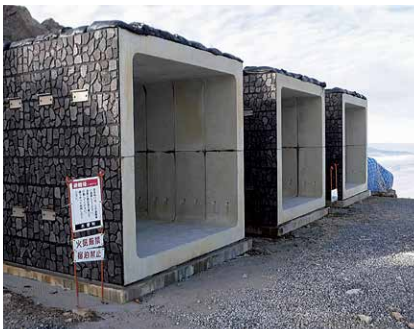
御嶽頂上山荘の跡地に設置した避難用シェルター（木）
