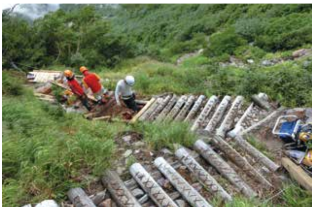
木段の壊れた箇所を補修する（小寺）
