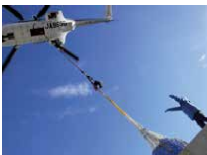
ヘリコプターによる荷揚げ作業（木）
