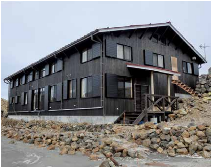
新たに建てられた二ノ池山荘。令和元年6月より営業を再開（小寺）
