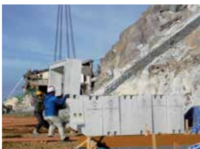
資材のコンクリートボックスを次々と搬入（木）
