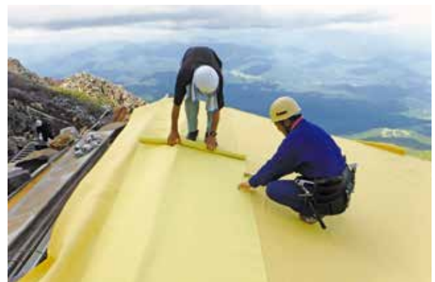
強度の高いアラミド繊維で屋根を補強（石）
