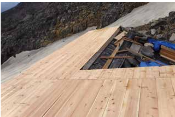
石室山荘の噴石対策工事。防衛大の山田浩之准教授が工法を指導（石）
