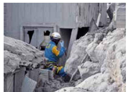
損壊の激しい山小屋を確認（警）
