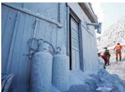
壁やガスボンベに火山灰がべったりと付着（東消）
